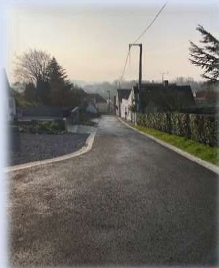
Les travaux de borduration et de voiries réalisés impasse des Lilas
