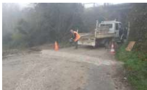
Surélévation rue du château au niveau du pont SNCF
