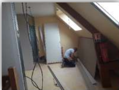
Pose de cloisons, et création de 2 chambres supplémentaires
